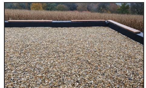
6 cm Rollschotter auffüllen
