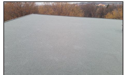
mit Schiefer oder Top Coat einfärben
