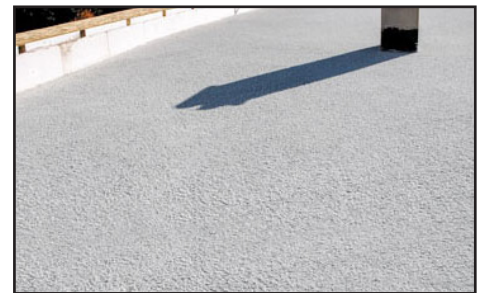
5 cm Estrich aufbringen
