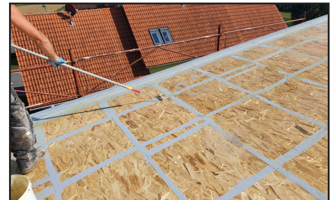
Stöße mit Taurus Elastic verschließen
