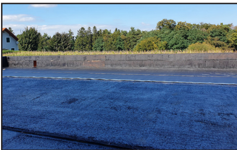
Aufbringung der Dampfbremse auf die Grundierung
