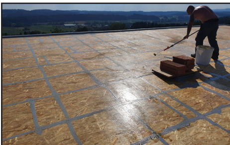
OSB-Platte grundieren
