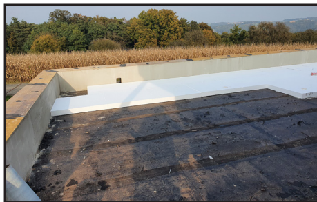
Legung der Wärme- und Gefälledämmung
