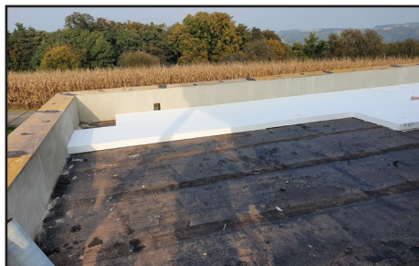
Legung der Wärme- und Gefälledämmung
