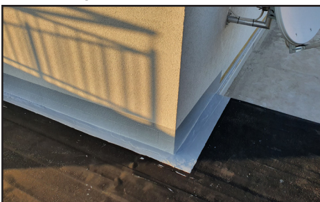
Anschlussdetails mit Flüssigkunststoff ausführen
