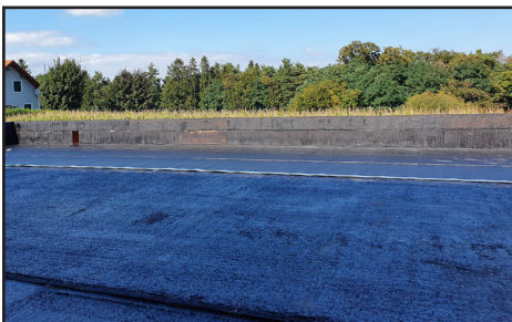
Aufbringung der Dampfbremse auf die Grundierung
