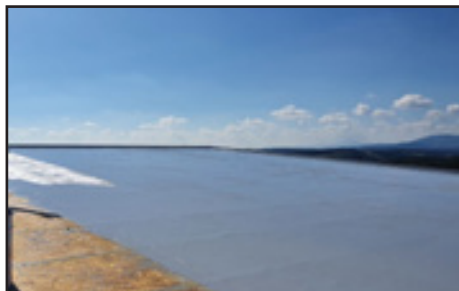
Mit Vlies und Flüssigkunststoff abdichten
